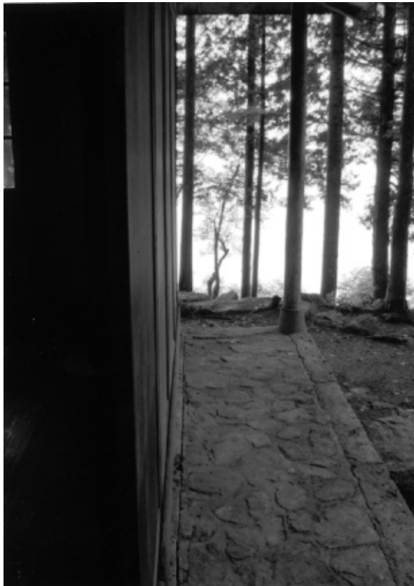
写真5 別荘の広縁への上り口の、たたき。(写真右手には湖に降りる石の階段がある)
