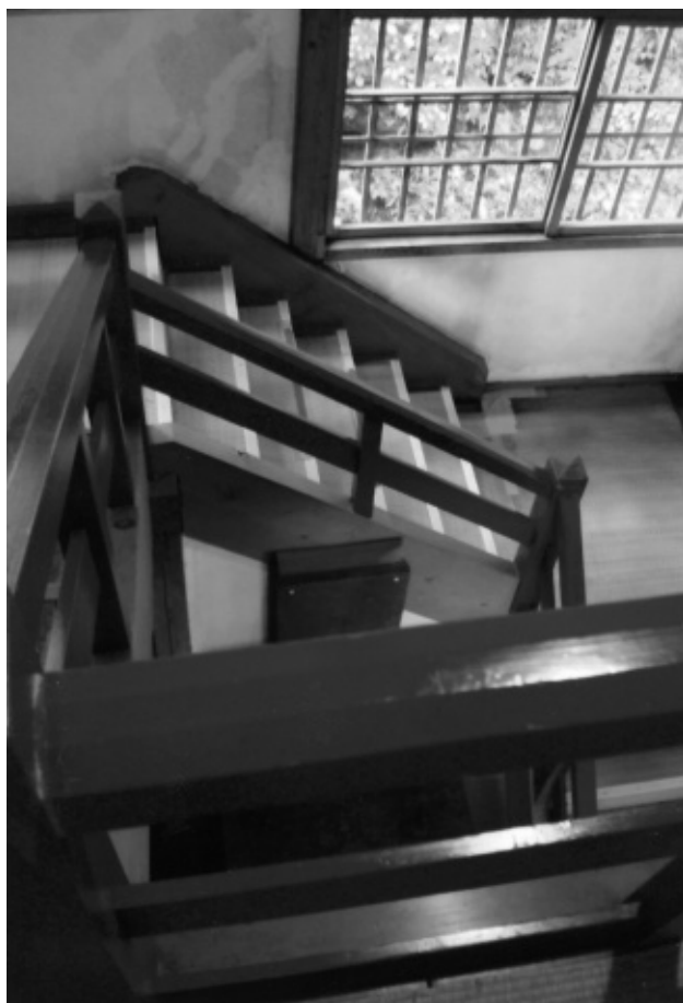
写真8 フランス大使館別荘 階段（二階から踊り場を見下ろす）
